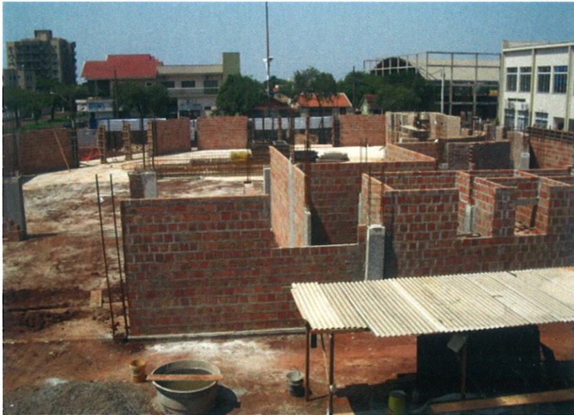
Sakristei und Ministrantenzimmer
